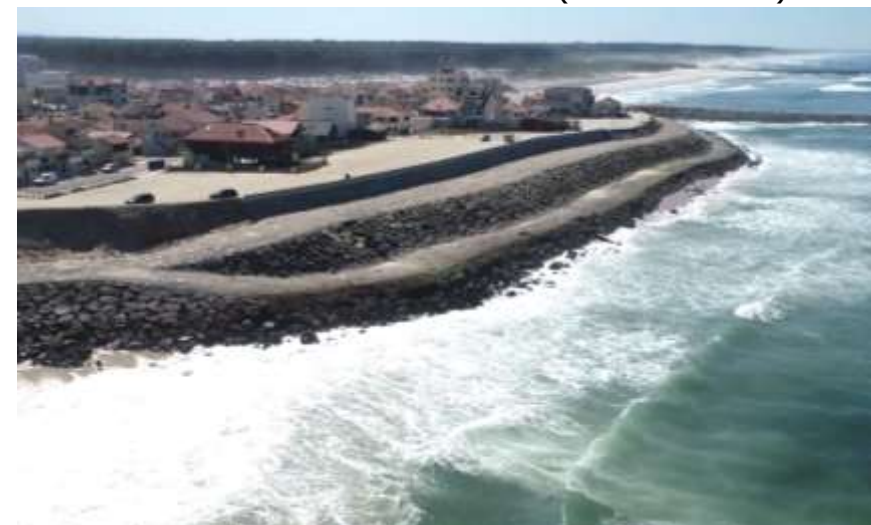
Esmoriz/Cortegaça (Ovar) Aumento da cota de coroamento (2008 e 2014)
