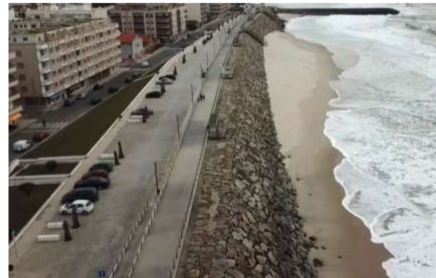
Vagueira (Vagos) Aumento da cota de coroamento (2014/15)
